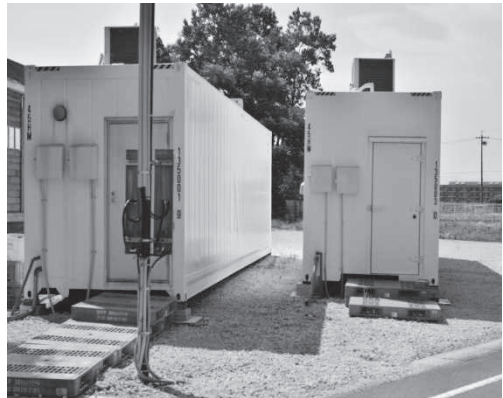
植物工場外観(本社)
